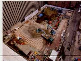
■理工学部駿河台校舎 6・9 号館解体の様子
